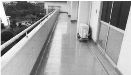
施工完了 バルコニー部南より
