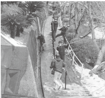
雪の中の撤去作業
