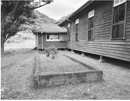
ブロック壁撤去後の情景
